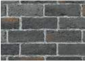
Standard Grouting การลงยาแนวแบบมาตรฐาน
