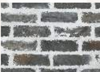
Over Grouting การลงยาแนวแบบปาดหน้า
