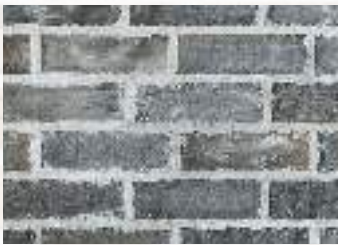
Full Grouting การลงยาแนวแบบเต็ม
