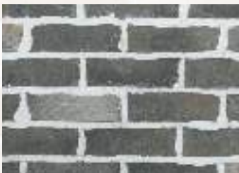
Weep Grouting การลงยาแนวแบบเส้น
